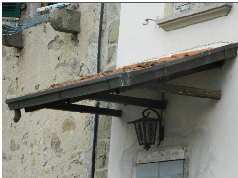
TETTOIA CON STRUTTURA LIGNEA E COPERTURA IN LATERIZIO
